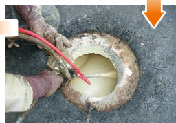
施工状況②
