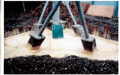
鉄塔塔脚保護
