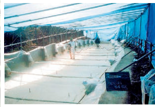
軽量盛土(R-PUR工法)
