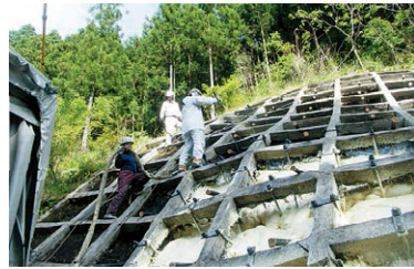
法面充填(法枠裏)
