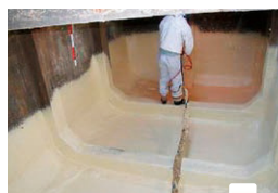
施工前状況①
