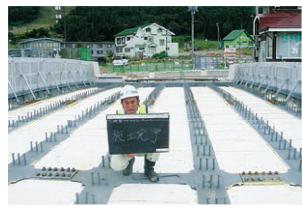
合成床版橋内部充填
