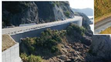
実際に施工した道路
