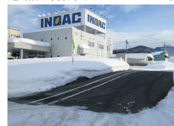
道路融雪利用 (北海道イノアック・美瑛工場)
