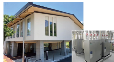
空調利用 (上松町庁舎)
