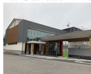
空調・道路融雪利用 (飯綱町庁舎)
