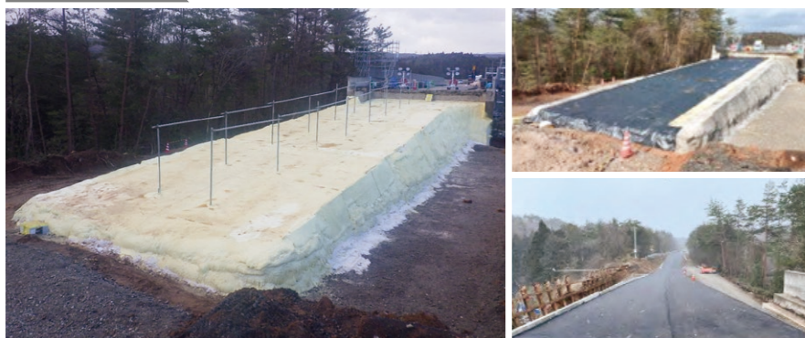
施工後の様子
