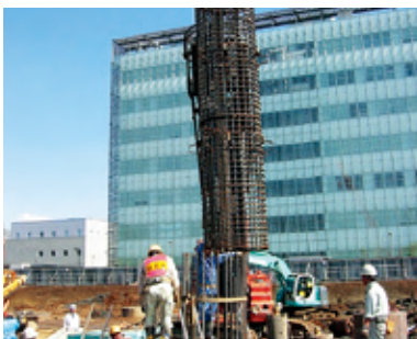
場所打ち杭利用
