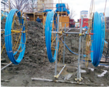
既製杭 Uチューブ 杭外周型(ヒートパイル工法)
