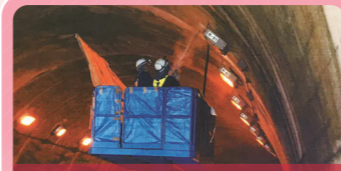
トンネル背面空洞充填 現場発泡ウレタン工法
