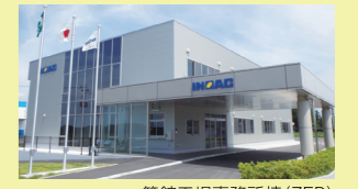
築館工場事務所棟 (ZEB)
