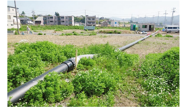
仮設下水配管 (東北震災復興)
