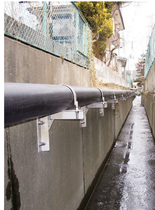
用水路側壁配管
