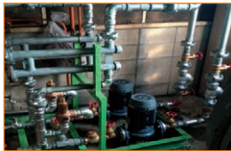
機械移設 及び設置
