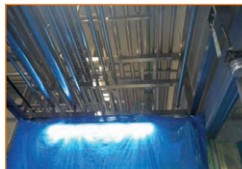
配管及び ダクト新設
