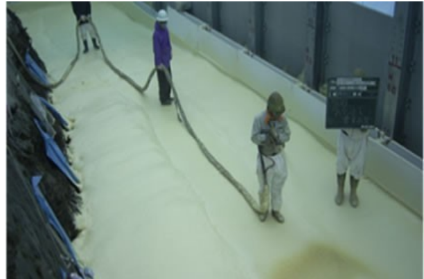
道路拡幅盛土
