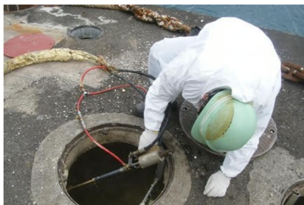
ポンツーン（浮棧橋）充填
